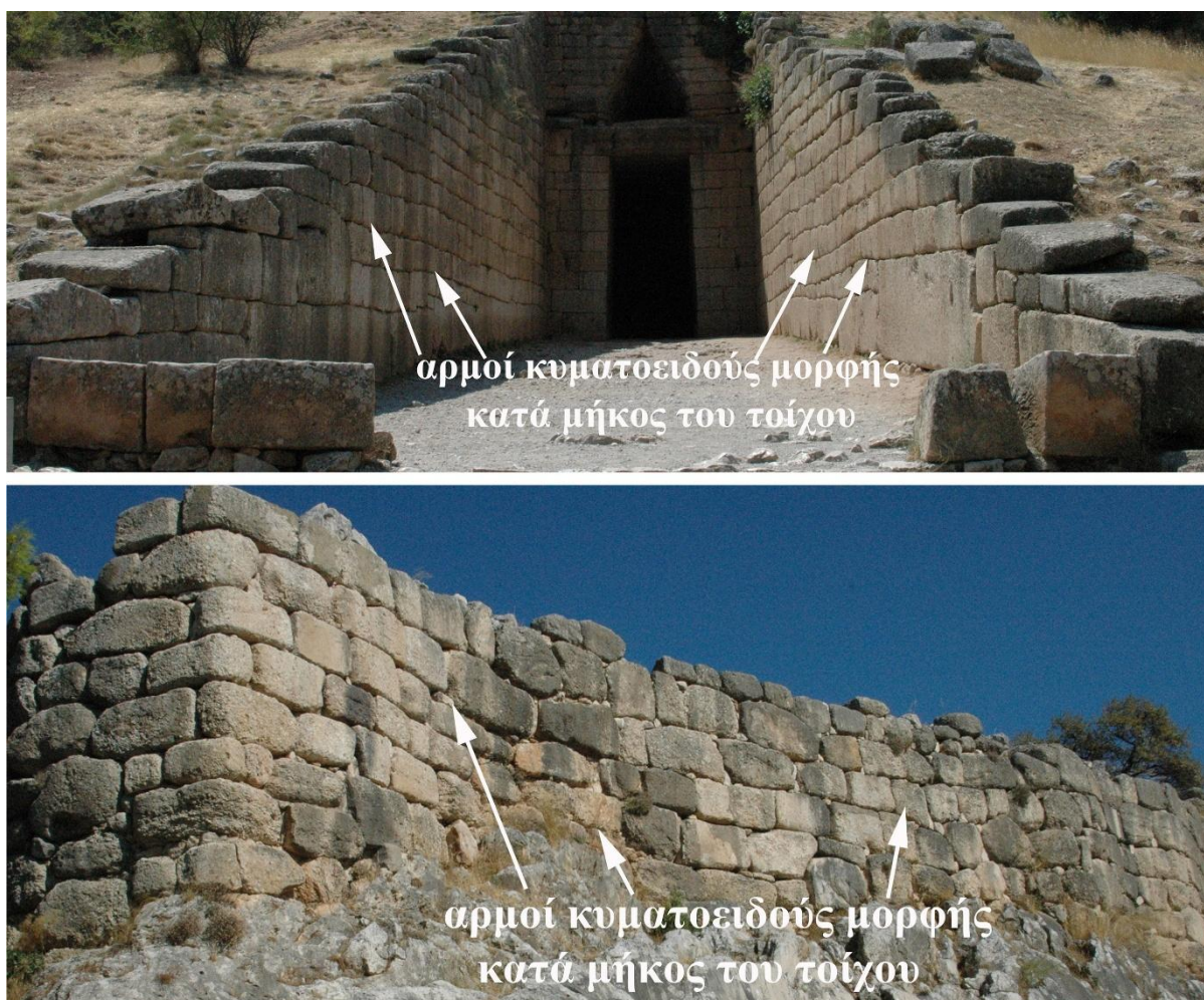
Εικόνα 16. Αρμοί με κυματοειδή μορφή κατά μήκος: Δρόμος του Θησαυρού του Ατρέα (άνω). Βορειοανατολικός Προμαχώνας των Μυκηνών (κάτω). [Φωτογραφίες του συγγραφέα].
