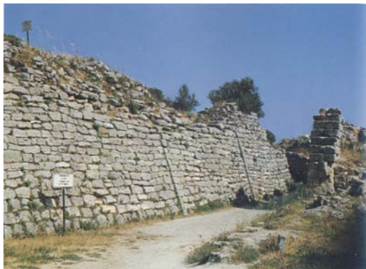
Σχήμα 11: Τα καλοχτισμένα τείχη της Τροίας (αριστερά) ενώ (δεξιά) το ασθενές σημείο -του οποίου το δεξιό τμήμα είχε βλαβεί πολύ από μεταγενέστερους οικοδόμους - και που βρίσκεται στα αριστερά του καλοχτισμένου τμήματος 271 .
